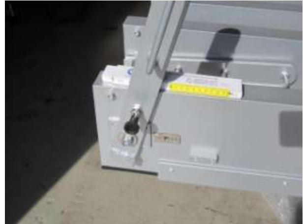
Bild 5-10: Dammbalkenelemente, Verschluss
