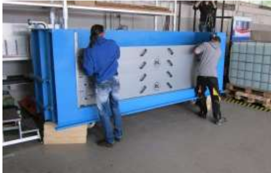
Bild 6.2-1: Einbau Dammbalken
