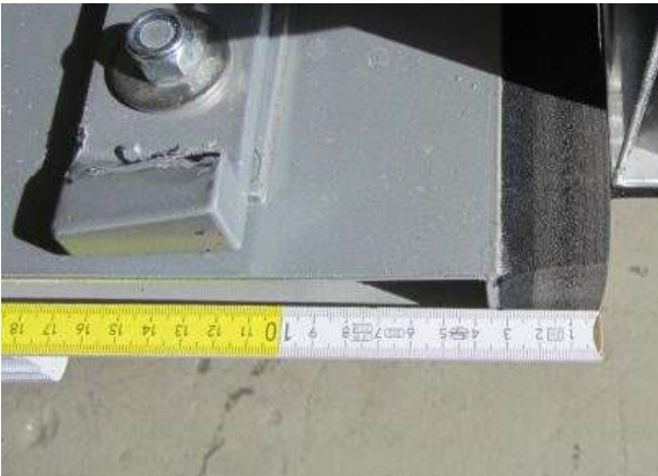
Bild 5-11: Untere Bodendichtung (DNP 50x2,5+1) weicht von den Planunterlagen ab (DNP 50x20)
