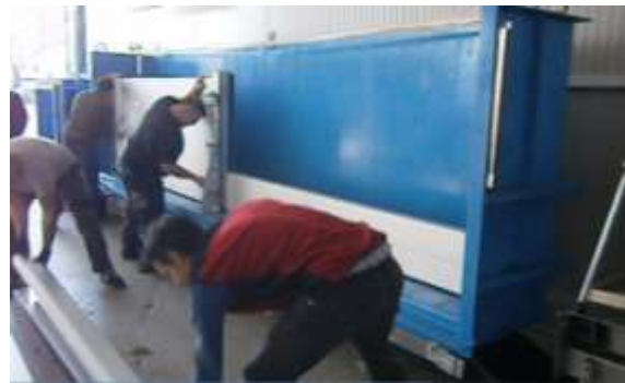
Bild 6.2-6: Einbau Dammbalken
