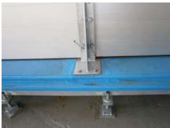
Bild 5-5: Unterer Anschluss der Mittelstütze
