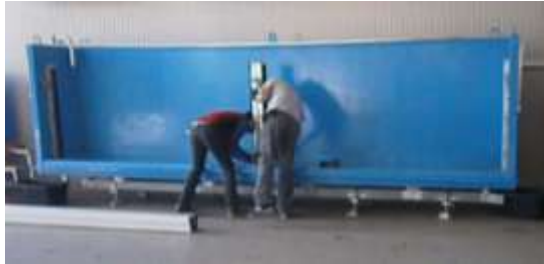
Prüfbox vor dem Einbau des Hochwasserschutzsystems
