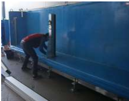
Bild 6.2-5: Einbau Mittelstütze
