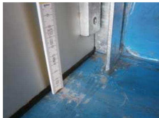
Bild 5-6: Unterer Anschluss des U-Aufnahme und Dammbalken mit Sohlendichtung
