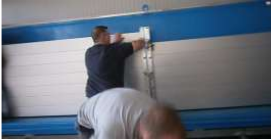
Bild 6.2-7: Fixierung der Dammbalken an der Mittelstütze
