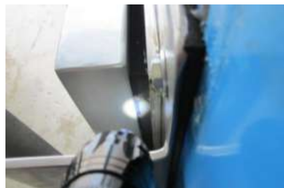
Bild 5-6: seitliche Befestigung der Messeinrichtung mit Dichtung
