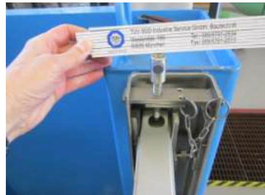
Bild 6.2-6: Fixierung der Dammbalken mittels Vertikalspanner
